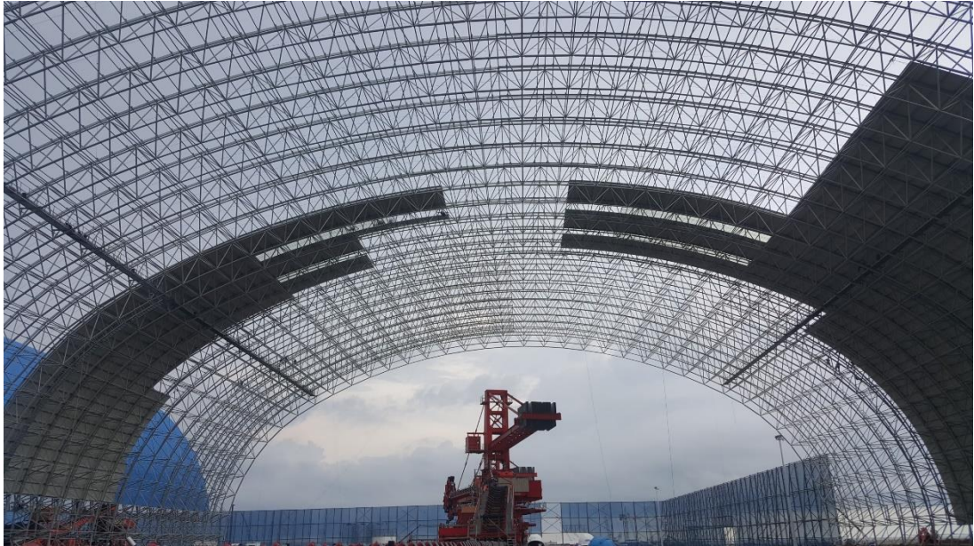
Hình 6-5: Hình ảnh thi công lắp dựng kết cấu thép kho than khô
